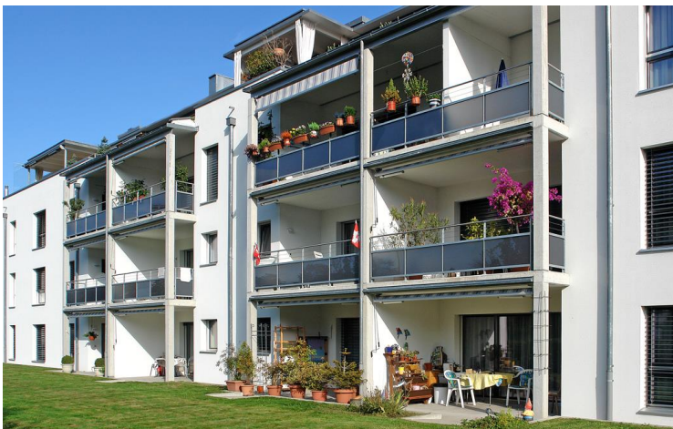
Lyssstrasse 8 und 10, Urtenen-Schönbühl
